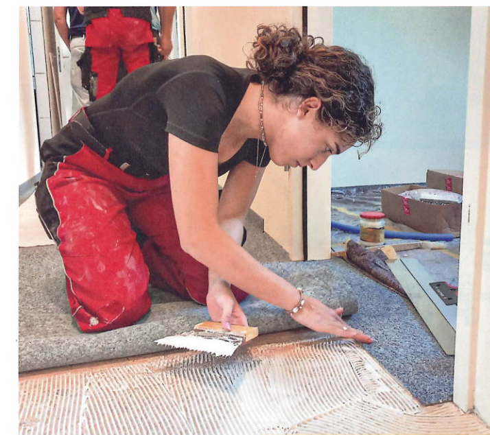
Oberstes Bild: Leann Gantenbein verlegt den Teppichboden. Mittleres Bild: Manuel Gort ist mit dem Aufbau der Aussenstuppe beschäftigt.
